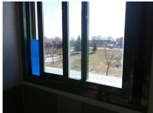
*Cartón protector para las ventanas traseras que coincidan con el puesto de un alumno. El aire sigue entrando por arriba con espacio suficiente y en días muy fríos o con mal tiempo, puede ser interesante.*
